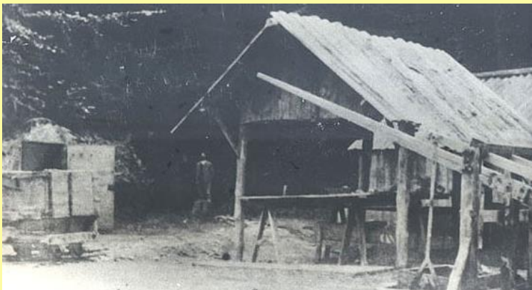
Usine et fonderie de Massiac
