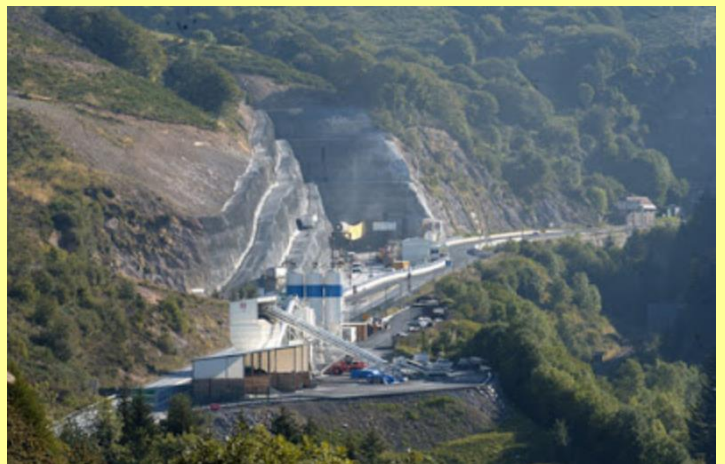
Entrée du tunnel côté St Jacques
